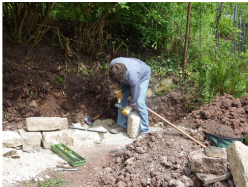
Arbeiten an der Trockenmauer (Bild: Draxler)
